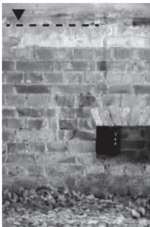
Fig. 12 通気口 内観より (点線は当初の床高さ)
