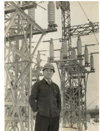
改良工事が完成した北海道電力北見変電所にて(1958年) Reformed Kitami electrical substation of Hokkaido Electric Power Company (1958)
