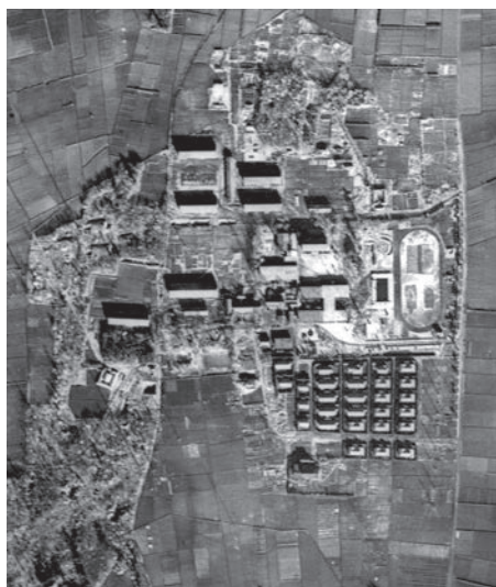
左：大和田通信隊（旧大和田町）
