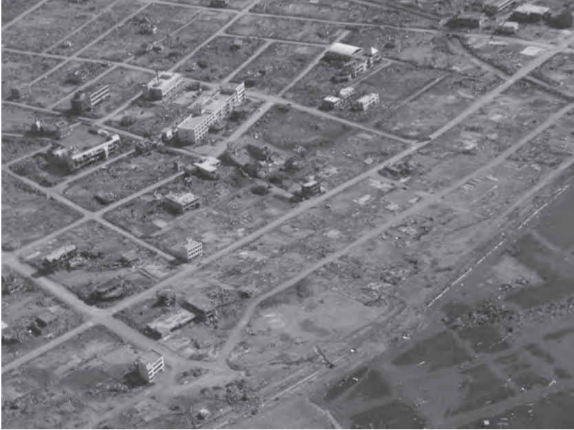
写真5-1 上空から捉えた陸前高田の市街地。左上斜めの長方形の大きな建物は陸前市役所。既に道路の「啓開」作業が完了しており、自衛隊の組織的能力の高さが分かる。平成23年10月10日～10月13日の期間、筆者は自衛隊岩手地方協力本部の支援で岩手県沿岸部の2回目の「現地調査」を行った。同市役所の内部は地震・津波被害に見舞われ、構造上の被害とは別に、1階から最上階の各廊下や床にはかなりの量の砂礫が堆積しており、さらに徹底的な破壊を被った市庁舎の中には、多くの行政資料を始め書簡類が散在していた。 田中伯知撮影（2011年4月5日午前9時09分）
