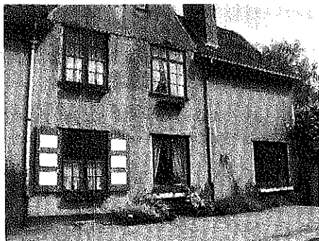
写真7 改造された一階の窓（真中と右）
