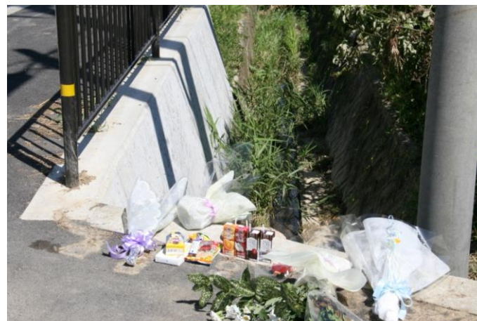
避難しようとした人たちは幅2mに満たない農業用水路上の高流で、向こう側（用水路下流）へ少なくとも6人が流されて死亡
