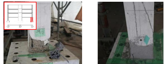
c) 補修方法②b: エポキシ樹脂モルタル補修
