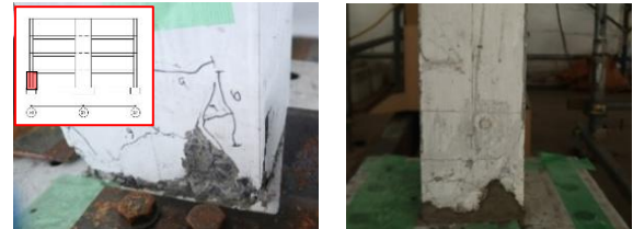
b) 補修方法②a: ポリマーセメントモルタル補修
