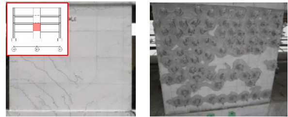
a) 補修方法①: エポキシ樹脂注入
