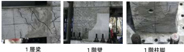
写真-2 補修後の様子
