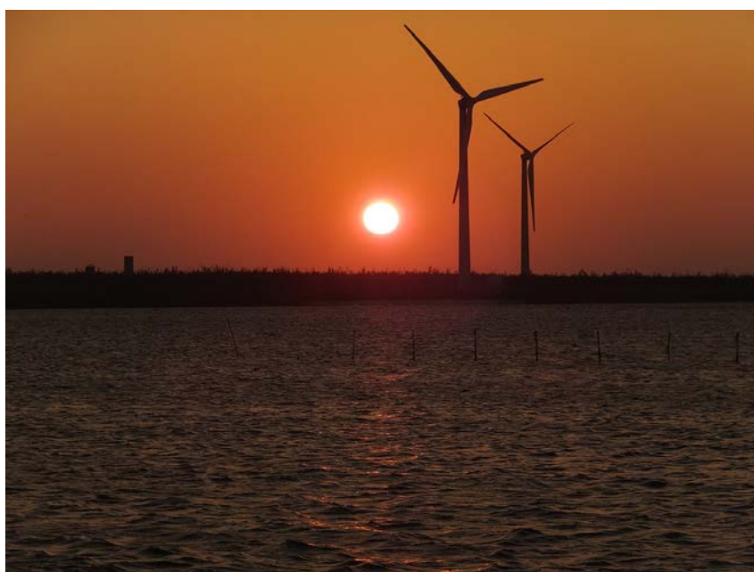
台中市高美湿地の風力発電設備
