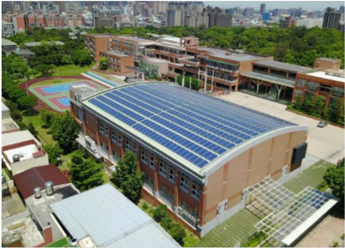
写真2 桃園市にある小学校の屋上型太陽光発電施設
