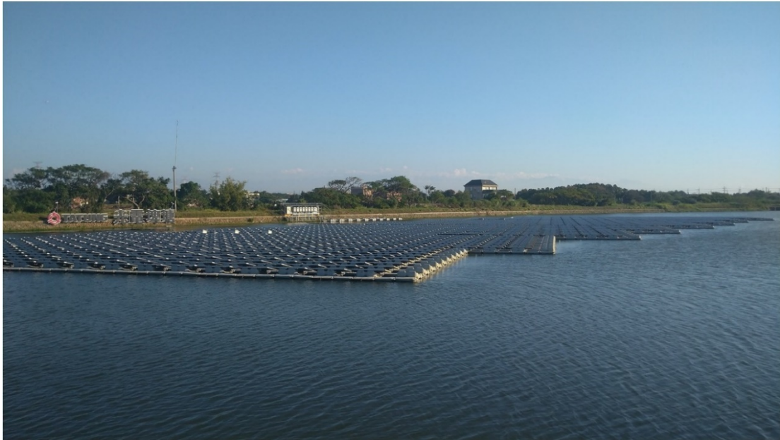
写真4 「桃園農業博覧会」の会場内に位置するため池の水面型太陽光発電施設
