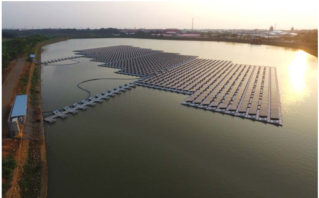
写真3 桃園市に位置するため池の水面型太陽光発電施設
