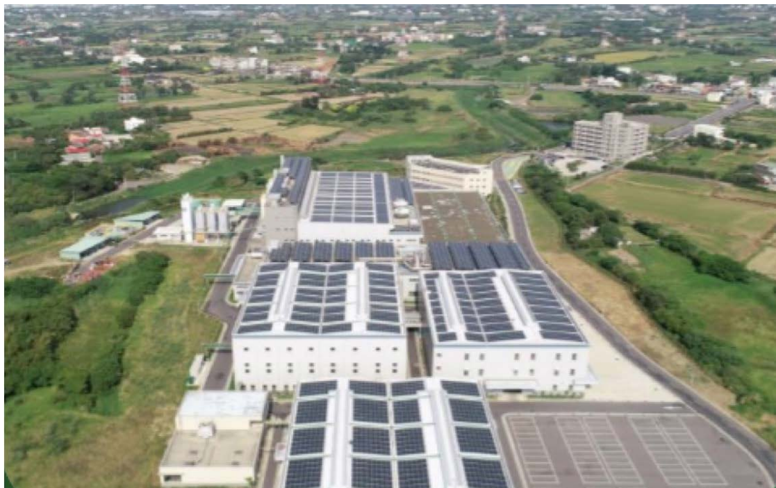
写真1 桃園市にあるプラスチック工場の屋上型太陽光発電施設
