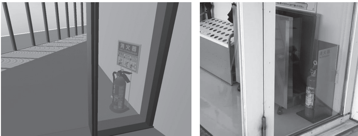
図 3 バーチャル空間内の消火器と実際の場所の消火器
