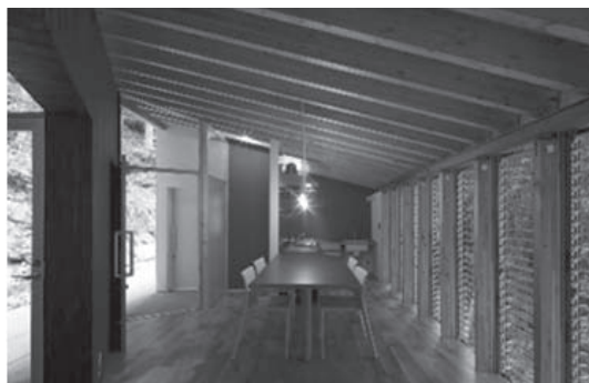
写真1 奥多摩町森林セラピートレイル 沢のステーション内部 左手山側に料理の空間がまとめられ、食事の空間は右手の沢に張り出す。開口部はすべてジャロジーであり、外部環境を直接的に味わうことのできるセラピーステーションである。 事業主：奥多摩町／設計、監理：オンサイト計画設計事務所、インフィールド
