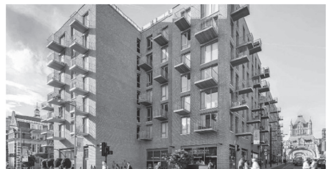
図6 市役所近くに建設されたアフォーダブル住宅 (出典: Berkeley Group)
