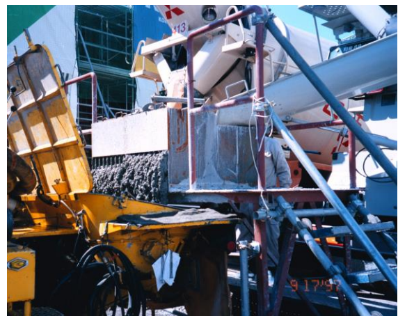
図-2 当初案に基づいた試験器を実施工にて使用
