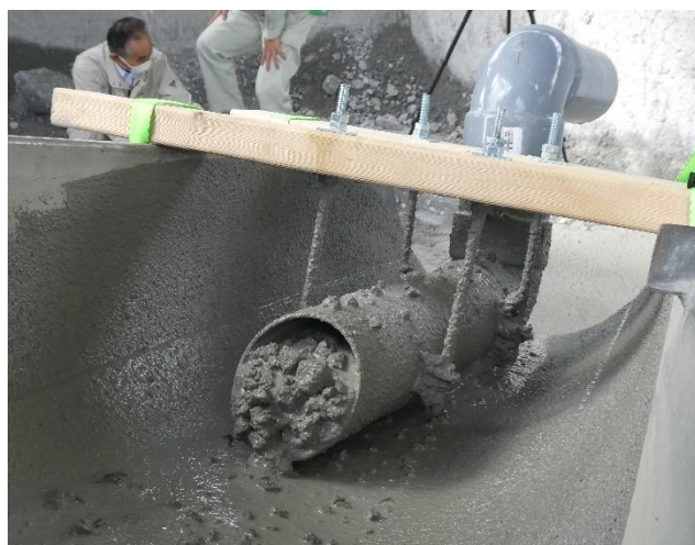
図-4 分離抵抗性に劣るコンクリートが鉛直曲管により停止：上昇できなかった粗骨材の滞留による
