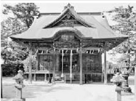
写真1 被災前の本殿 (山元町役場提供)
