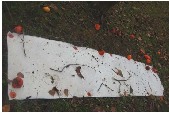
図 85 手順1 ゼオライトシートを敷設.
