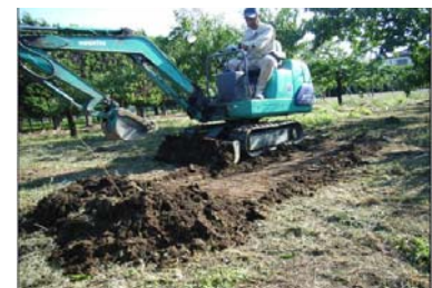
図 35 バックホー排土板利用
