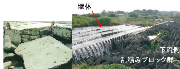
図1 堰下流河床低下被災のメカニズム
