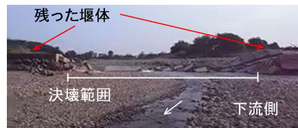
図2 下流河床低下での堰被災
