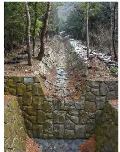
法量・構造等 石張水路工、張石の欠円断面排水路、196m
