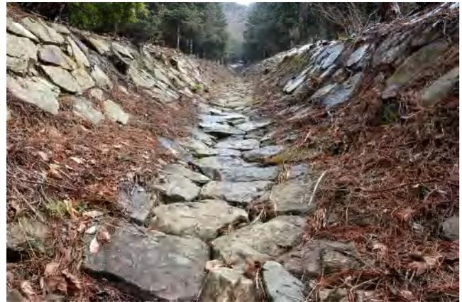
宇曽川流路工は、雨水や湧水による山腹斜面の侵食を防ぐ砂防施設として建設された排水路(溝)で、宇曽川ダムの上流 1.8km。平成の名水百選に選ばれた「山比古湧水」から 10 分ほど宇曽川溪谷を歩いた唐櫃ヶ淵の右岸斜面にあります。
