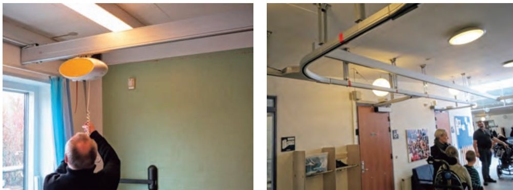
写真5・6 上部取り付け式の移動用具 (各部屋間（トイレを含む）を移動できるようにレールが取り付けられている)
