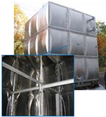
写真-1 ステンレス製パネルタンク (SUSタンク)
