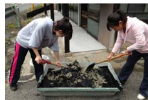
(c) 土間コン打設
