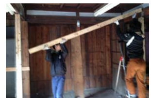
(d) 内壁工事
