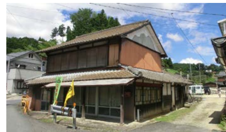
図-5 対象空き家の改修前外観
