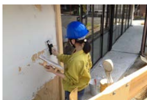
(e) 外壁の漆喰工事
