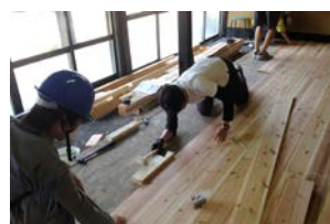
(f) フローリング工事
