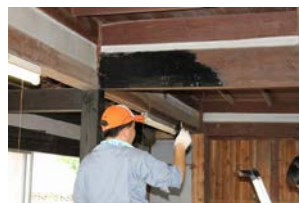
(b) 梁や柱の塗装
