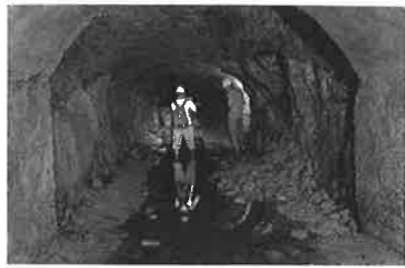
写真3 地下壕調査の様子。懐中電灯を片手に暗闇を進む
