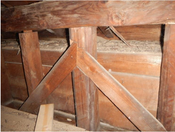
図7 筋かいの設置状況
