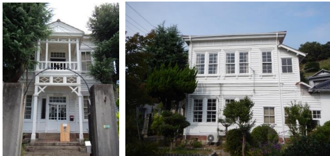
図1 調査対象建物外観（西面・南面）
