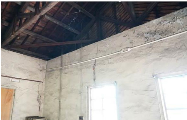
図 13 補強のために設置されたと思われる鋼棒
