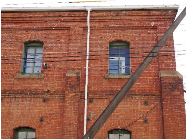
図8 第八庫北側の外壁
