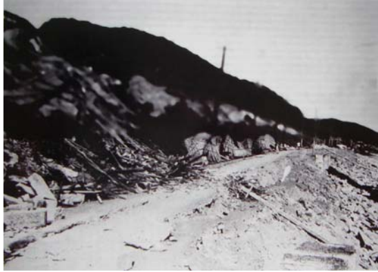
鎌倉市七里ガ浜の 津波による被害
