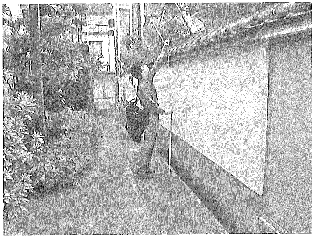
(2) 街路の幅員、塀倒壊の危険度、階段などの調査
