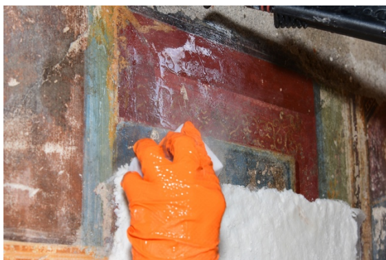
図3 高圧スチームによる蜜蝋の除去
