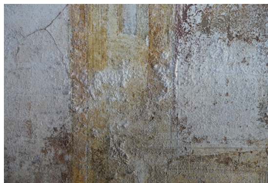
写真4 進行した塩類風化
