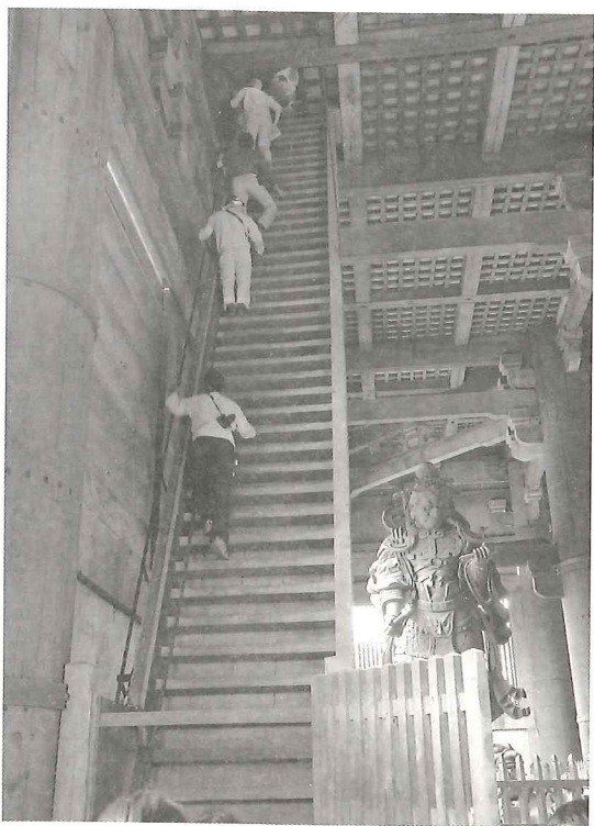
東大寺大仏殿小屋裏へと続く階段を登る
