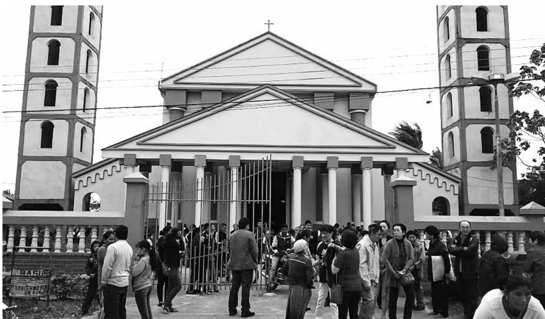
写真2 : 1998年に建て替えられたサンファンカトリック教会（2016年8月21日主日ミサ後 筆者撮影）
