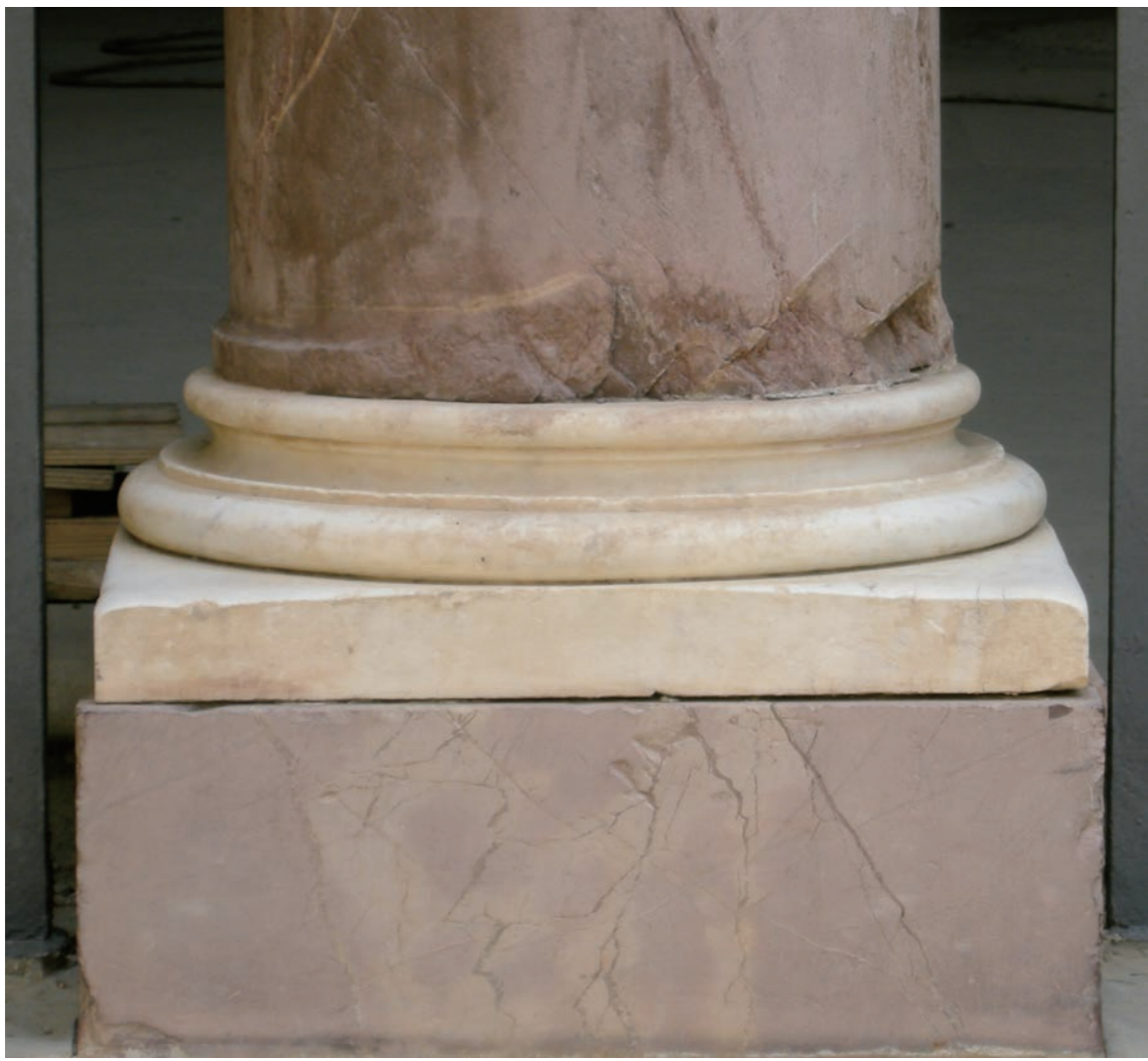
図5：アッティカ式柱礎（フィレンツェのポーポリ庭園内ブオンタレンティの洞窟のファサード、ジョルジョ・ヴァザーリ設計、1556-1560年）| 白い石の部分は、上から順に、上の円盤、平縁、溝付き円盤、平縁、下の円盤、方盤から構成されている。 出典：筆者撮影
