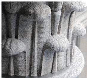
図1 日銀本店のコリント柱頭の葉のディテール。中央脈が立体的にかたどられ、水平の葉脈が彫られている。葉の先端はあまり薄くならず厚みを持つ。
