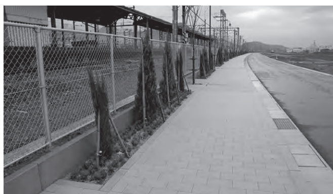
鉄道境界部にコニファーで修景した片側歩道の区画道路
